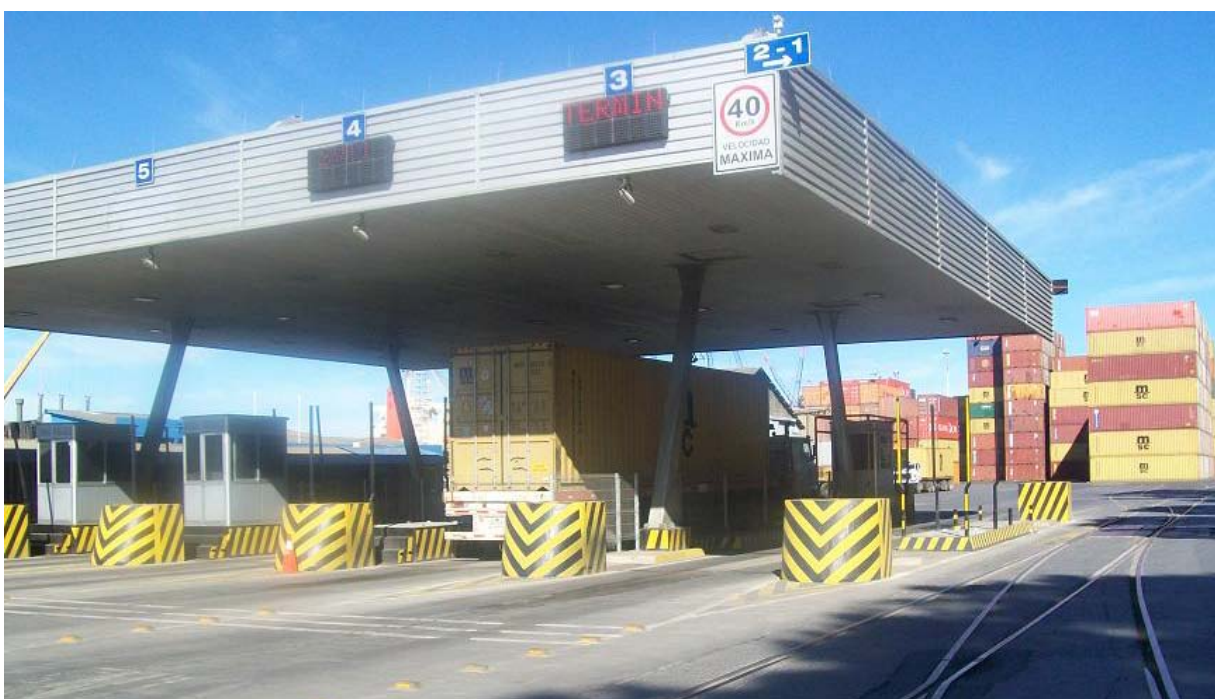
Ingreso de camiones y ferrocarril a Puerto de San Vicente
