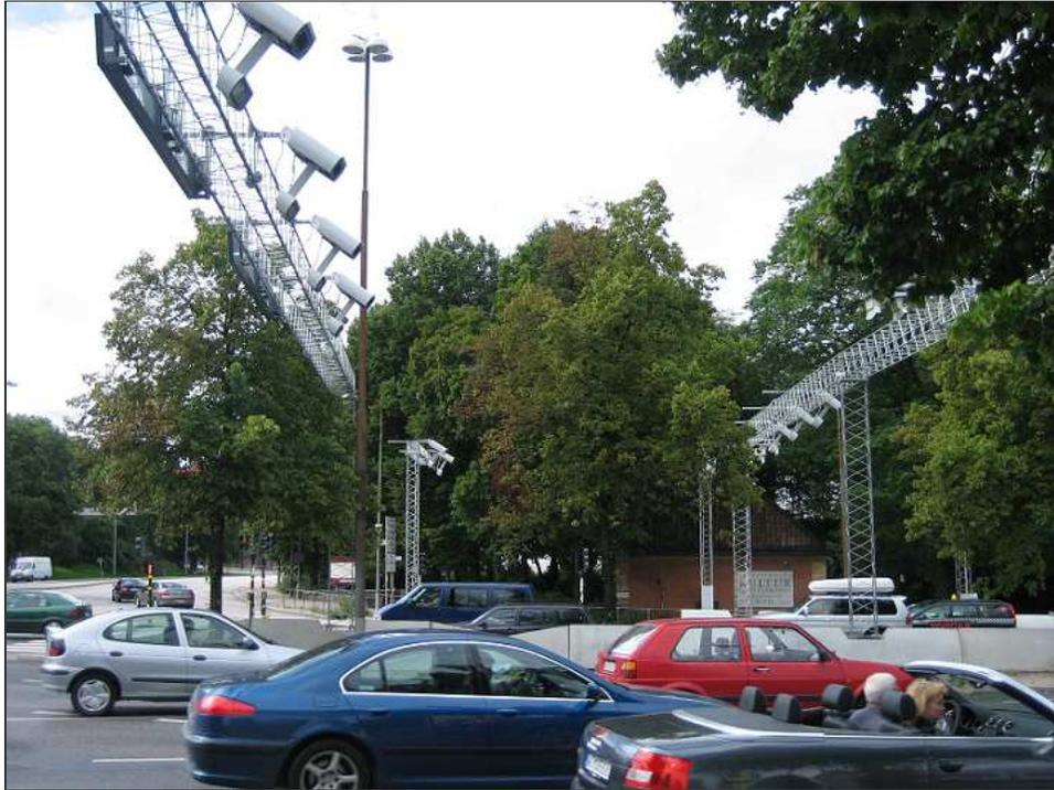
Puede apreciarse cómo en el caso de Costanera Norte se ha requerido sólo un pórtico, en vez de los pórticos dobles en Estocolmo y Singapur. Ello requiere que existan unos brazos que se extienden hacia el frente del pórtico para poder distanciarse y dar los ángulos para los distintos elementos que componen el pórtico (en este caso el sistema de detección y clasificación de vehículo).
