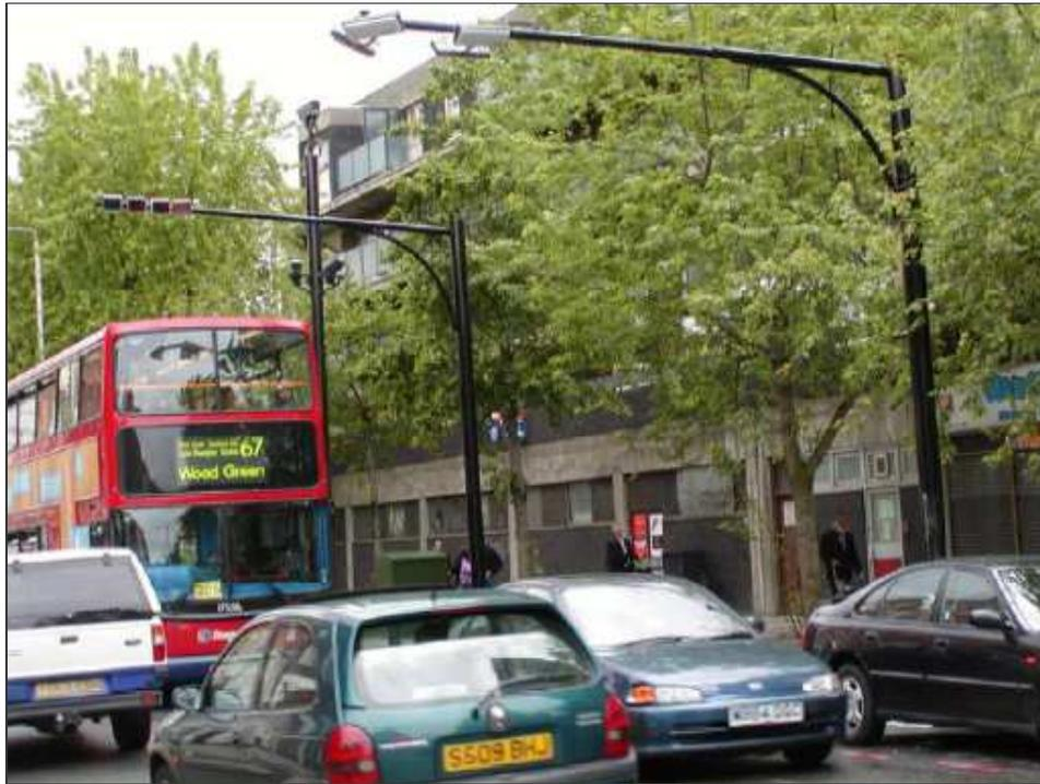
Puede notarse que en este caso hay dos postes para tarificar dos pistas en la dirección izquierda a derecha. El primer poste, a la derecha de la imagen, soporta las cuatro antenas para comunicarse con los transponders, las que están orientadas a las dos pistas de circulación de interés. El segundo poste, cercano al bus de dos pisos, soporta cuatro cámaras digitales para capturar imágenes, clasificar vehículos y fiscalizar infractores.
