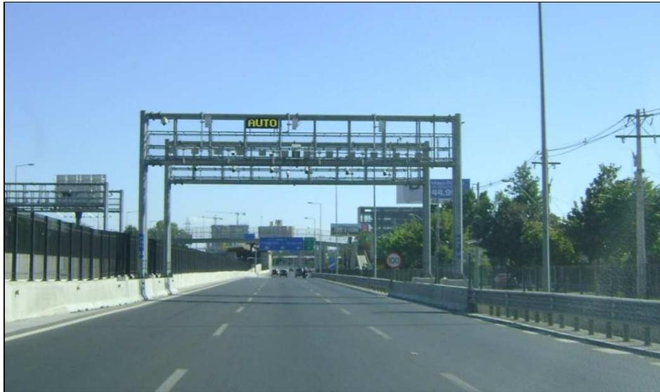
**FIGURA 7-7 PÓRTICO UTILIZADO EN EL ESQUEMA DE TARIFICACIÓN VIAL DE LA CIUDAD DE ESTOCOLMO, SUECIA**
